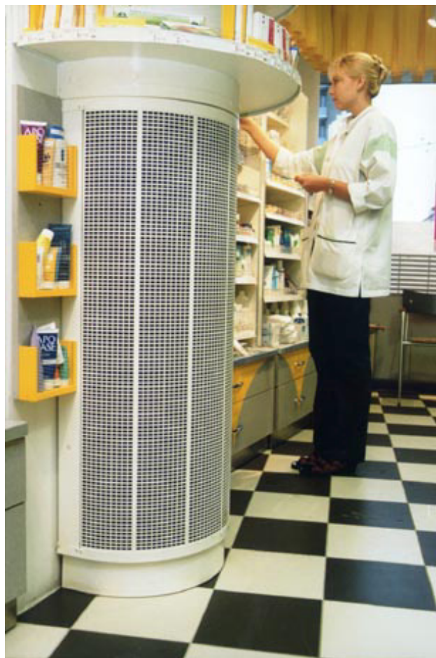
Piennopeuslaitteen periaatteena on syrjäyttävä ilmanjako. Laitetta käytettäessä ei yleensä synny vedon tunnetta.
